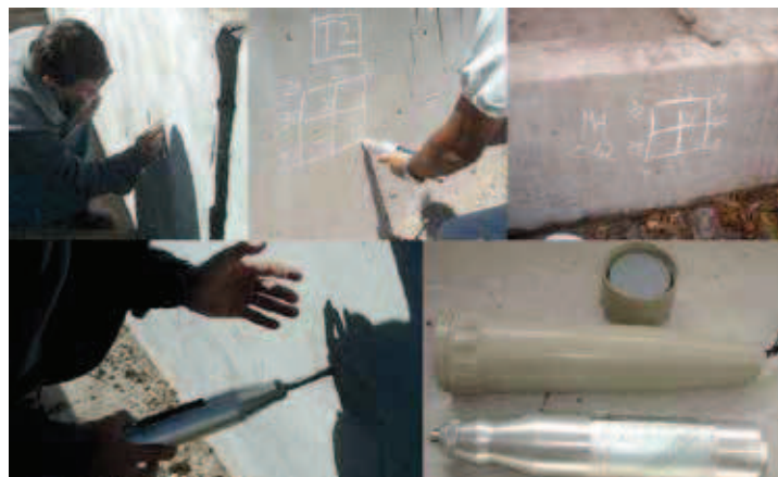
Fig. Fotografías de ensayos de esclerometría
